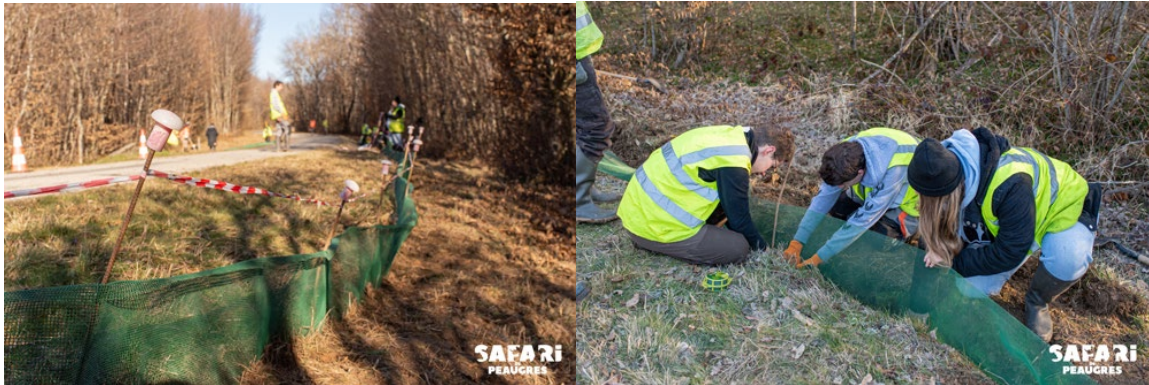
Figure 7 : Mise en place de filet de protection pour les amphibiens (source : https://www.safari-peaugres.com/actualites/des-installations-pour-la-protection-des-amphibiens )
