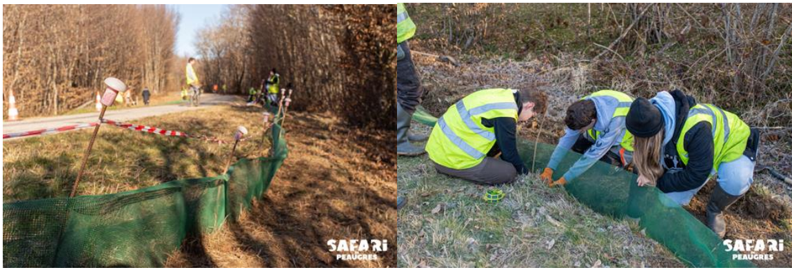
Figure : Mise en place de filet de protection pour les amphibiens (source : https://www.safari-peaugres.com/actualites/des-installations-pour-la-protection-des-amphibiens )
